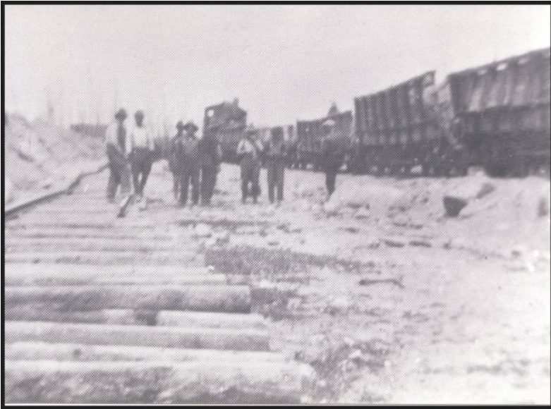
début de construction
